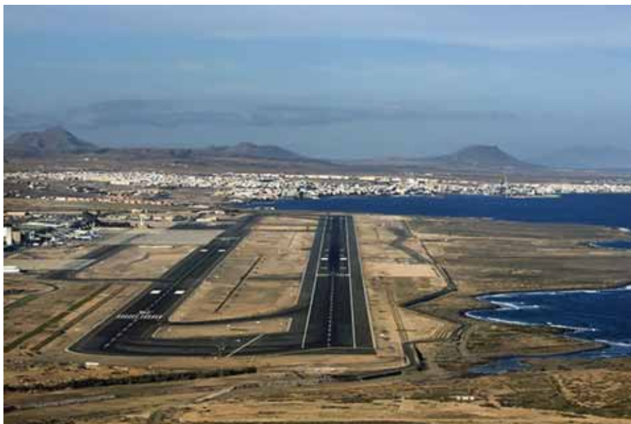
Aeropuerto de El Matorral, en Fuerteventura, al sur del Puerto del Rosario, donde tuvo que avistarse el mismo objeto que vieron a bordo de la Atrevida .
