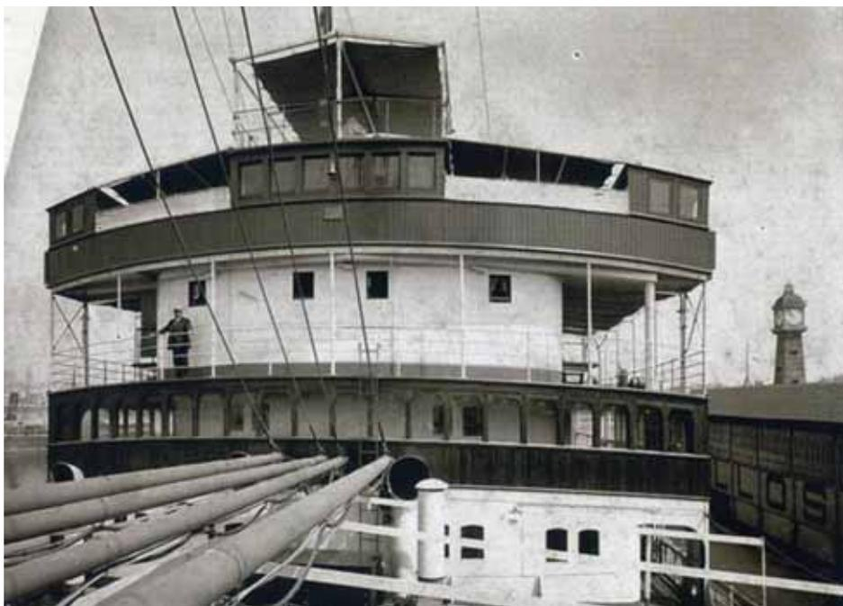
Cubierta de proa y puente con amplias “bacaladas” (aleros) del *Príncipe de Asturias*, donde pueden apreciarse las características típicas de estos buques: cubiertas despejadas llenas de entoldadas, grandes ventiladores, confinados y pequeños espacios de superestructura.
